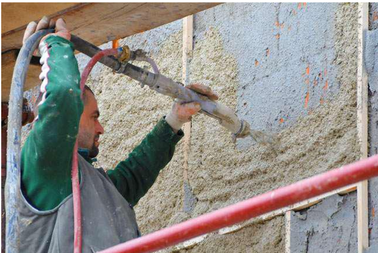
Baunit ThermoExtra purškiamas mašininu būdu (foto Beodom).
