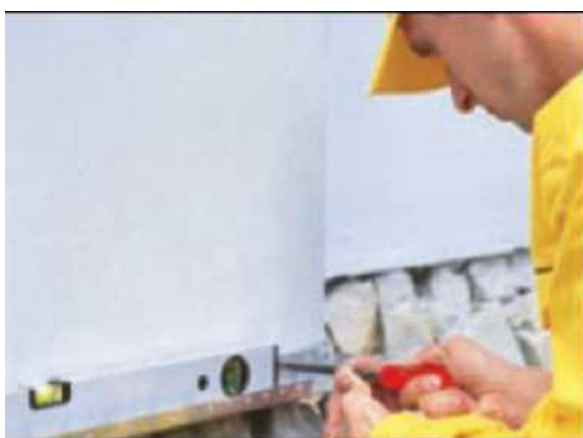
9 pav. Cokolinio profilio tvirtinimas
