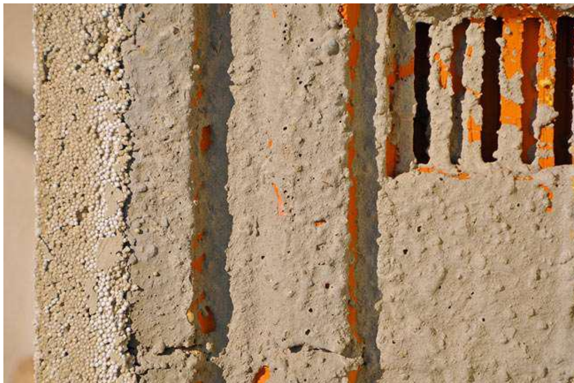
Taip atrodo angokraštis nuėmus medinius žyminius (foto Beodom).
