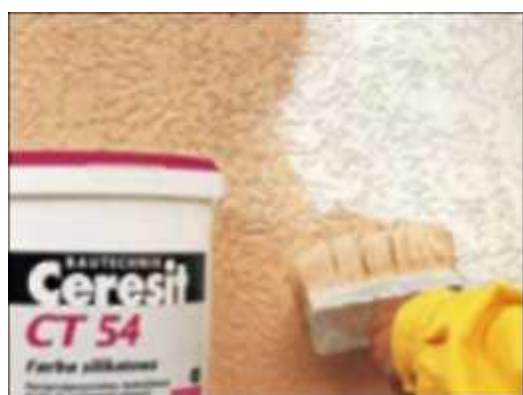
34 pav. Mineralinių tinkų dažymas
