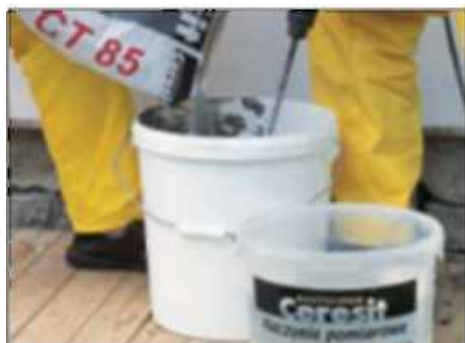
20 pav. Armuojančio mišinio paruošimas
