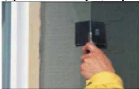
27 pav. Kraštų armavimnas
