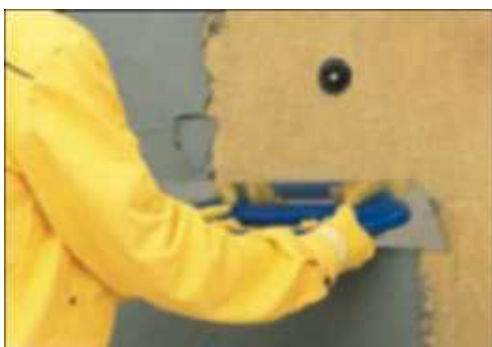
24 pav. Plokščių paviršiaus armavimas
