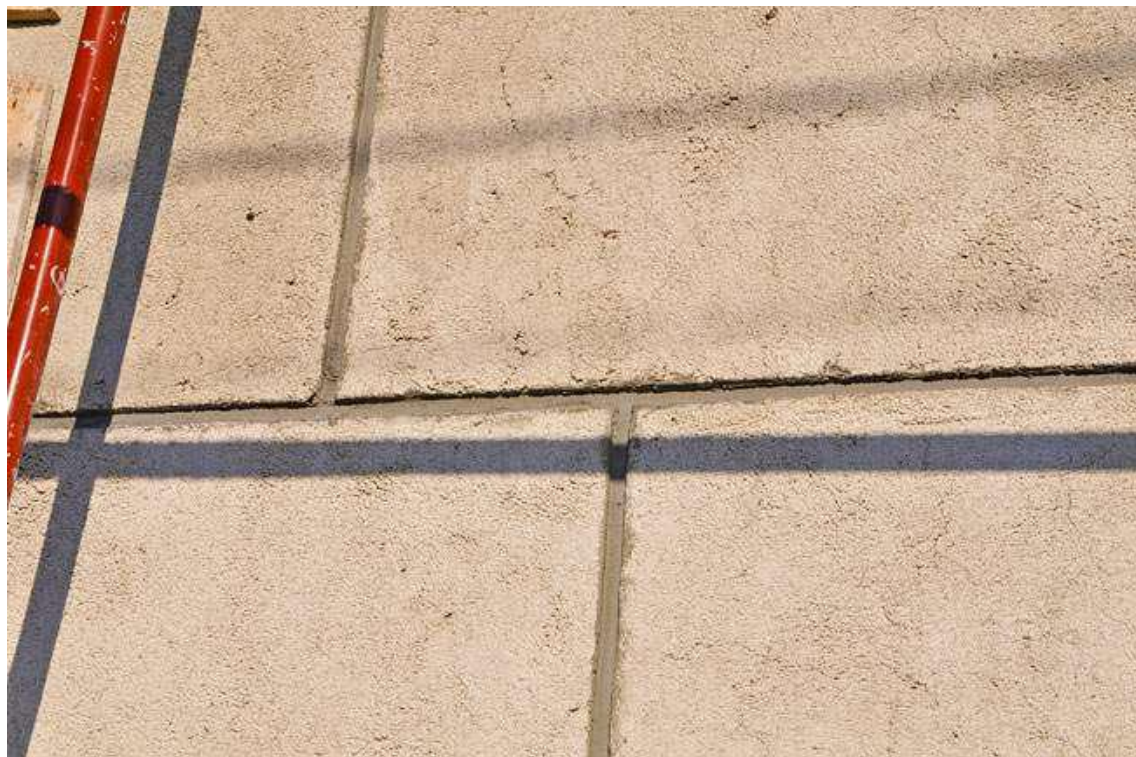
Termo tinkas visiškai sausas. Mediniai žyminiai pašalinti ir užtaisyti tarpai (foto Beodom).
