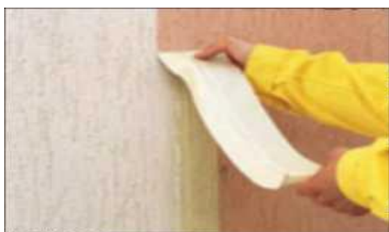
33 pav. Skirtingų spalvų tinkų sujungimas
