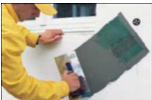
21 pav. Papildomas tvirtinimas langų ir durų kampuose
