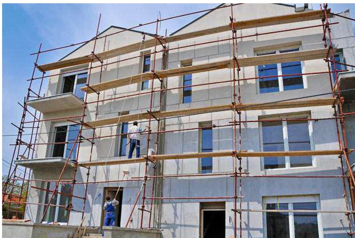
Fasado gruntavimas Baumit UniPrimer (foto Beodom).
