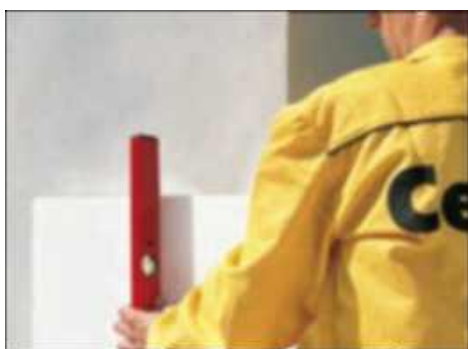
13 pav. Plokščių vertikalumo kontrolė
