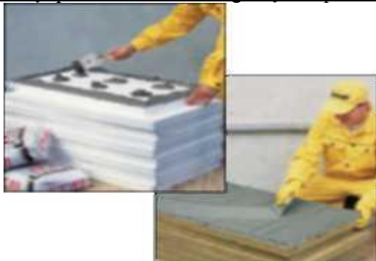
11 pav. Mišinio tepimas ant plokščių
