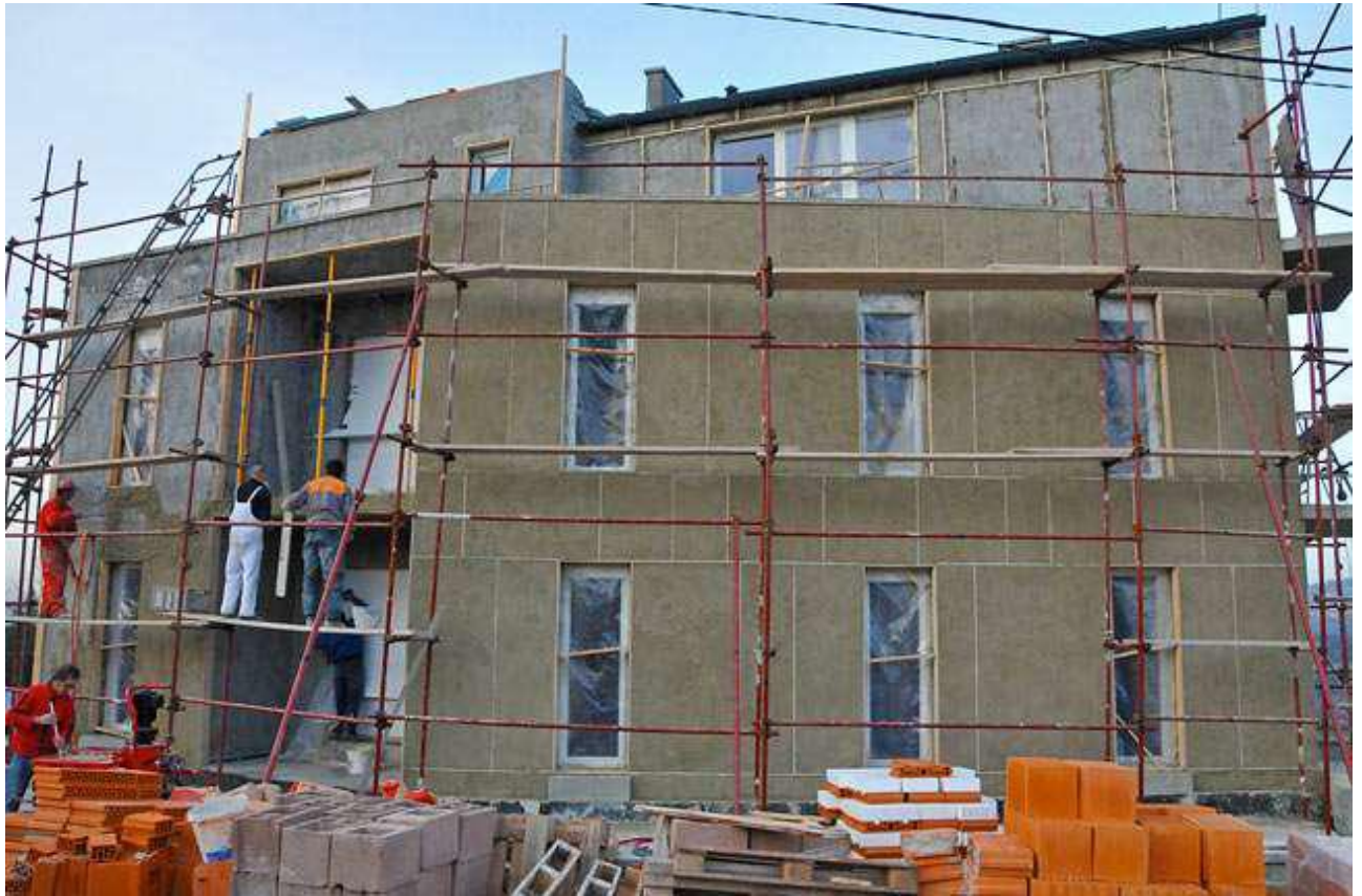
Tinkavimas termotinku (foto Beodom)
