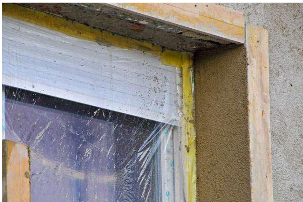
Angokraščių tinkavimas (foto Beodom).
