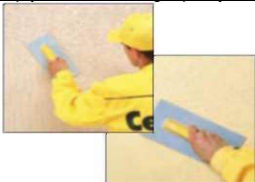
32 pav. Plonasluoksnio tinko užtrynimas
