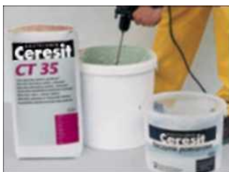
30 pav. Mineralinio tinko paruošimas
