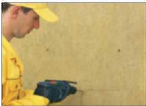
15 pav. Skylių gręžimas mechaniniams laikikliams
