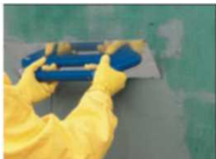
26 pav. Tinklelio armuoto sluoksnio glaistymas
