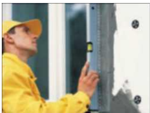
22 pav. Kraštų apsaugojimas metaliniais profiliais
