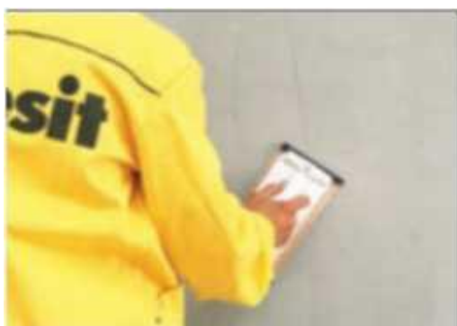
28 pav. Smulkių nelygumų išlyginimas
