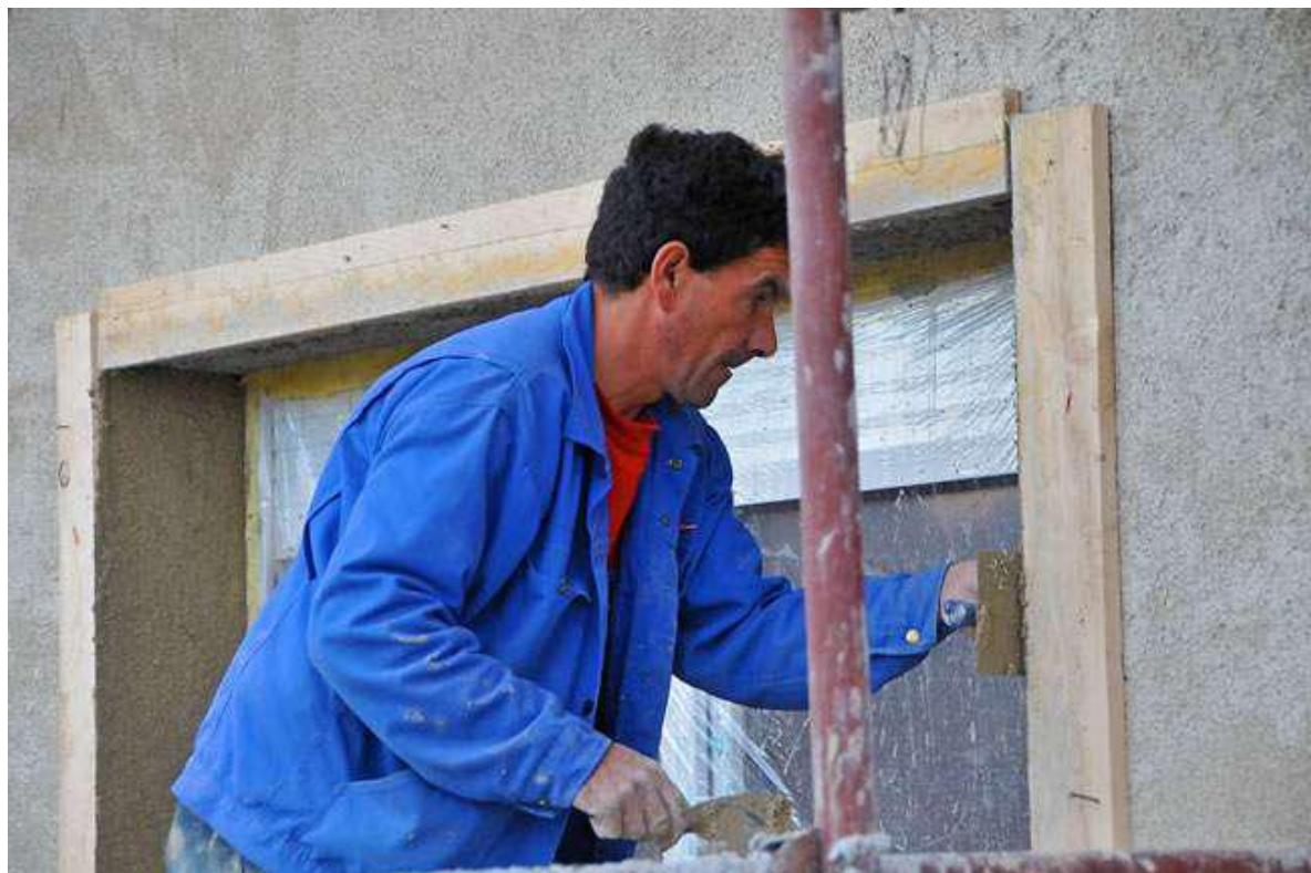
Angokraščių tinkavimas (foto Beodom).
