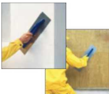
12 pav. Termoizoliacinių plokščių klijavimas
