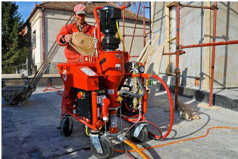
Mišinio Baunit ThermoExtra pilamas į tinkavimo mašina PFT G4 (foto Beodom).
