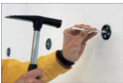
16 pav. Polistireno plokščių papildomas tvirtinimas
