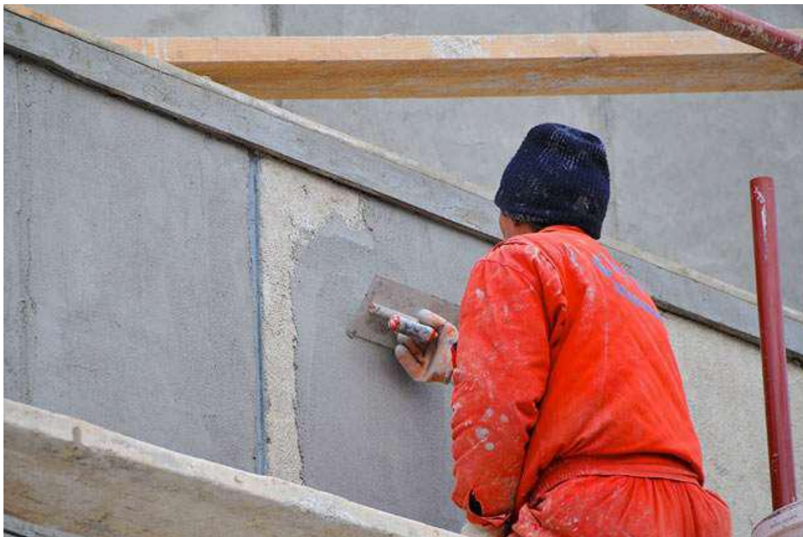
Fasado armavimas (foto Beodom).
