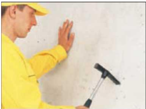
7 pav. Esamo pagrindo įvertinimas
