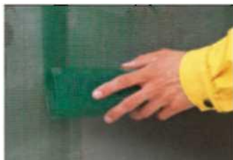
25 pav. Stiklo pluošto tinklelio klijavimas
