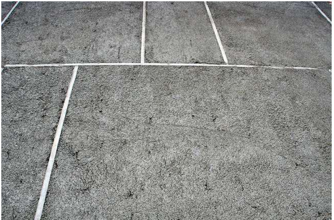
Tinkavimas termotinku (foto Beodom)
