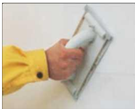
14 pav. Izoliacinių plokščių paviršiaus šlifavimas
