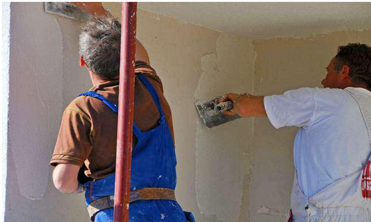
Tinkavimas Baumit EdelPutz Extra (foto Beodom).
