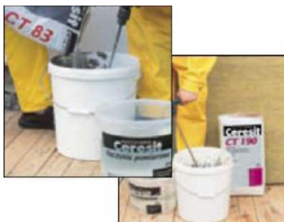
10 pav. Klijuojančio mišinio paruošimas
