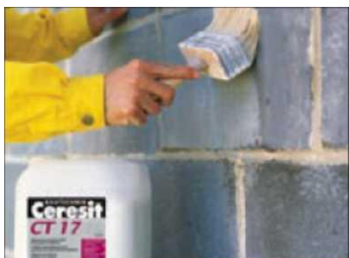
8 pav. Pagrindo gruntavimas
