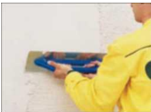
31 pav. Plonasluoksnio tinko uždėjimas
